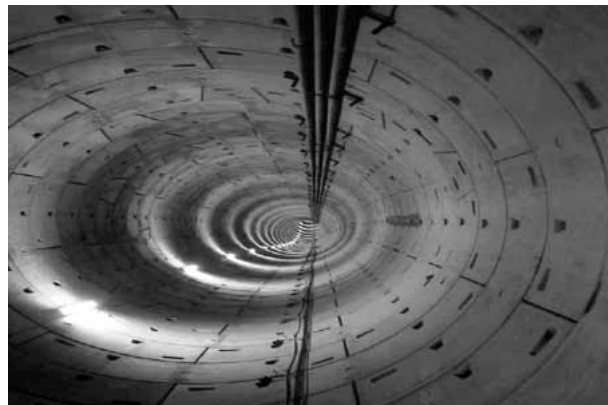
写真28 デリーメトロ1期 地下鉄土木工事 B工区 パテルチョーク=ラジブチョーク駅間のTBMトンネル (JICAご提供)
