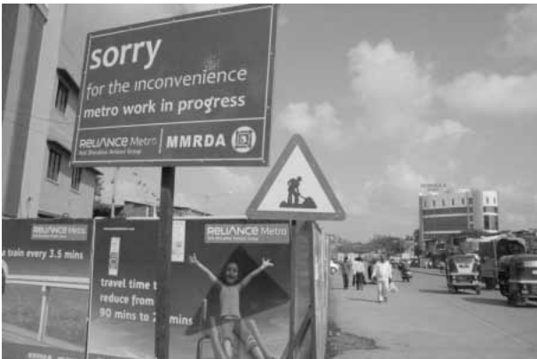
写真41 写真40と同じ道路沿いのムンバイメトロ1号線建設現場
