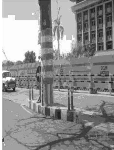
写真30 デリーメトロ1期 工所用フェンスの設置、 歩道の確保、そして樹木の保護の風景 (JICAご提供)
