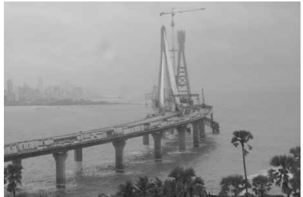
写真22 ムンバイで建設中のインド初の海上高速道路 Bandra-Worli Sea Link。工事が遅れている。（2008年9月13日雨天撮影）
