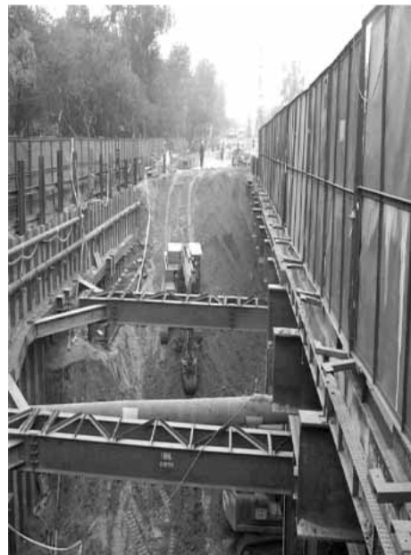
写真24 デリーメトロ1期 地下鉄土木工事 MC1A工区開削トンネル工事(JICAご提供)
