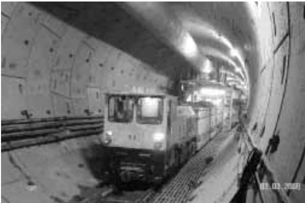
写真31 デリーメトロ2期トンネル工事現場 清水建設を含む5社JVが進めている地下土木工事における土 圧シールドマシンの操作状況。ディーゼル機関車が土砂を引い ている。2008年3月3日撮影（JICAご提供）
