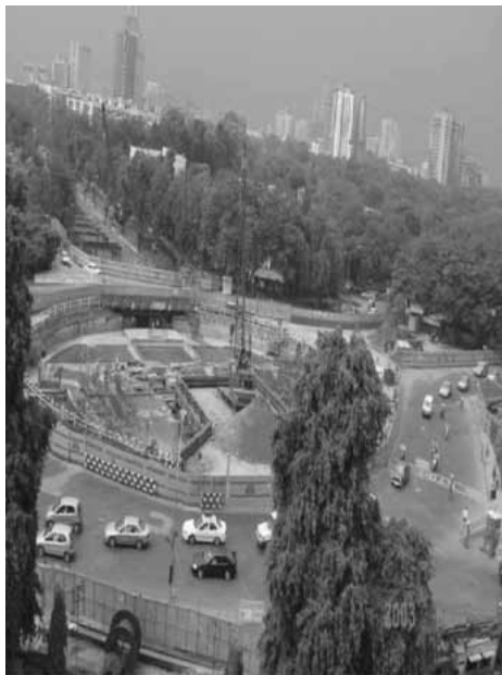
写真23 デリーメトロ1期 地下鉄土木工事 MC1A工区開削工事 コンコース建設(JICAご提供)
