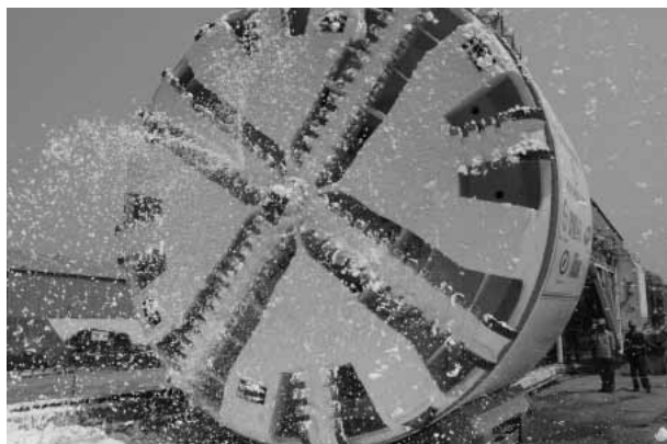
写真35 TBM(トンネルボーリングマシン) 2007年11月デリー市内ナンロイ地区土圧式シールド機試運転(清水建設の5社コンソーシアム手配)(DMRCご提供)
