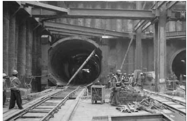
写真37 デリーメトロ2期工事 BC18工区の工事現場（JICAご提供）
