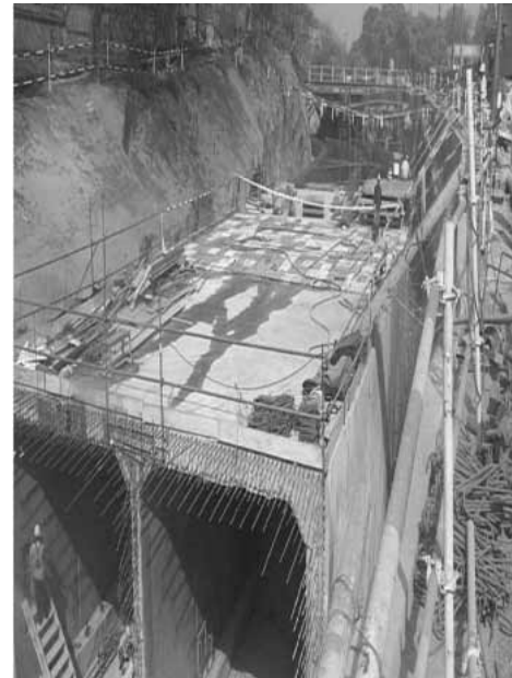
写真26 デリーメトロ1期 地下鉄土木工事 MC1A工区 開削トンネル工事（JICAご提供）
