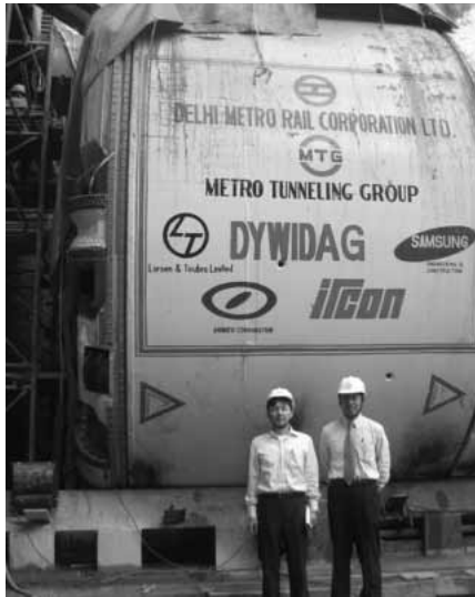
写真36 日本大使館・平石一等書記官（国土交通省ご出身）とJICAニューデリー金駐在員。2007年12月24日TBM稼働に際し土木工事現場をご視察。
