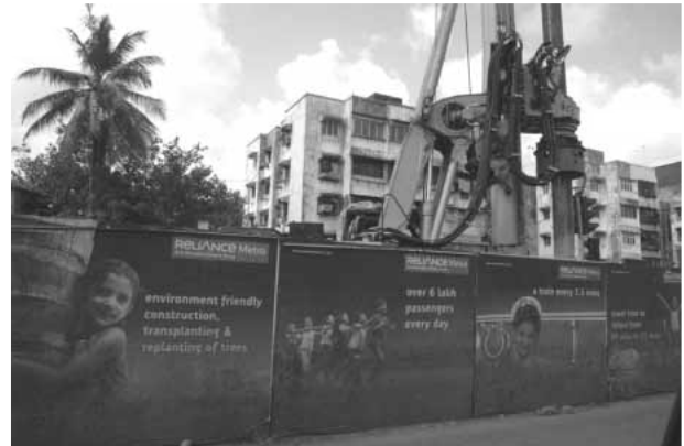
写真42 写真40と同じ道路沿いのムンバイメトロ1号線建設現場
