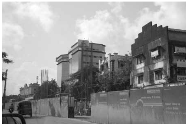
写真40 1号線建設現場
